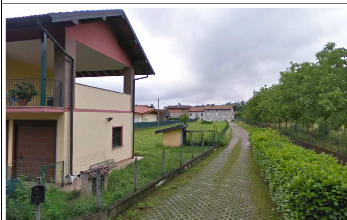
Ripresa fotografica n. 2 in direzione sud lungo Via Cascina Campana
