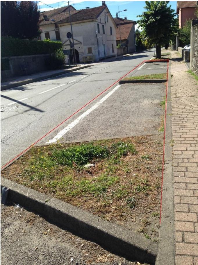
03\_vista di Via Zanotti\_ individuazione di parte dell'intervento di rimozione aiuole e rifacimento asfalti (intervento 1.)
