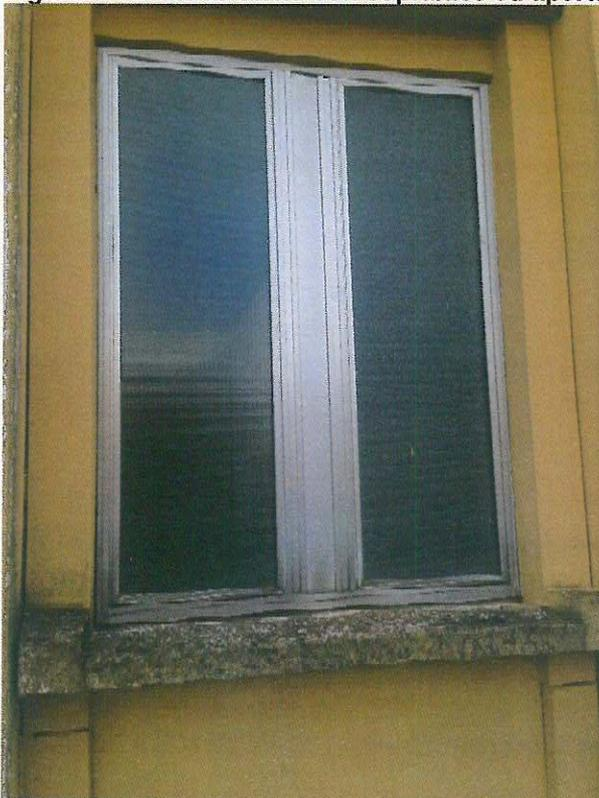
**Figura 4. Serramento a doppia battuta con fisso centrale.**
